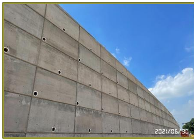
擋土牆完成模板及洩水管對線對
