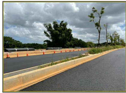
中央分隔島以鋼模施作完工前後
