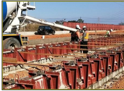
中央分隔島以鋼模施作完工前後
