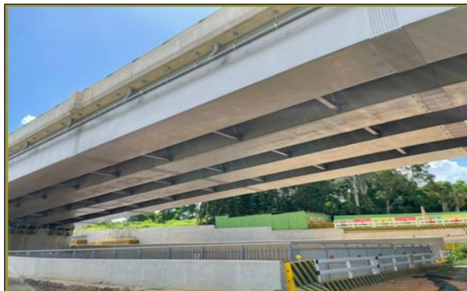
鋼橋與欄杆選色及混凝土一致性
